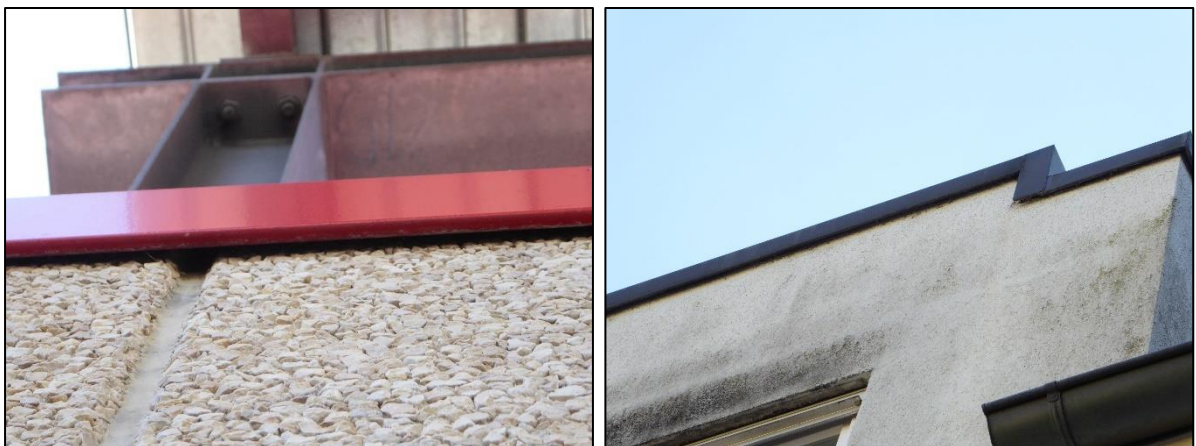
Abbildung 6: Für gebäudebewohnende Fledermäuse geeignete Attiken an den Gebäuden der Bergstraße 9 (linkes Bild) und der Allee 1/3 (rechtes Bild).
