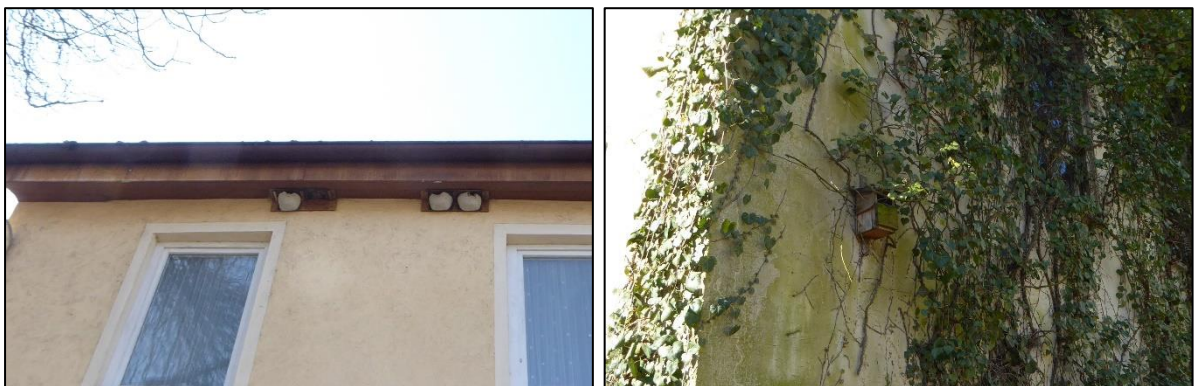
Abbildung 10: Künstliche Nisthilfen für die Mehlschwalbe am Gebäude der Seestraße 10 (linkes Bild) und für Nischenbrüter am Gebäude der Allee 5 (rechtes Bild).
